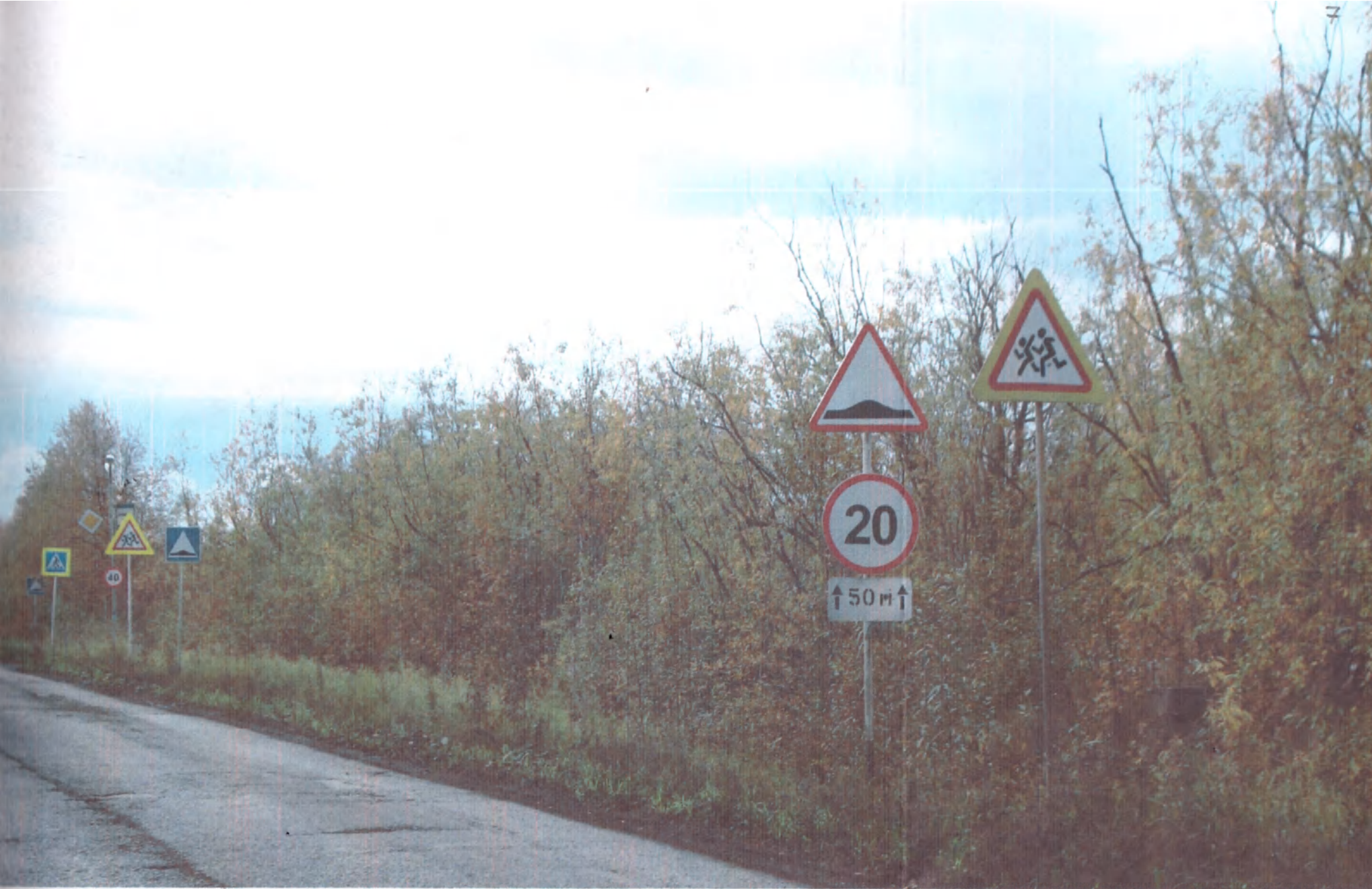
ОШ №6" остановка " Школа" по ул.Южная с ограничением скорости и пешеходным переходом
